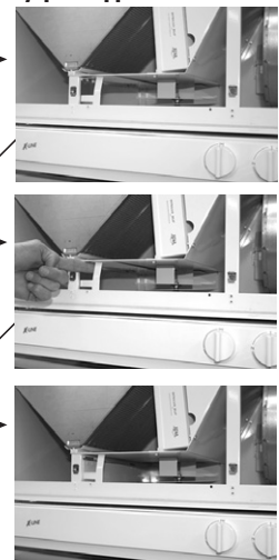
By-pass spjæld ved sommerdrift Spjældet sættes til sommerdrift ved at trække låsen mod dig selv.
